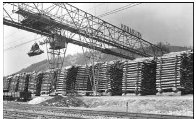
Holzkrane 1930 bis 1990 - 60 Jahre Wahrzeichen der Gemeinde Ferndorf
