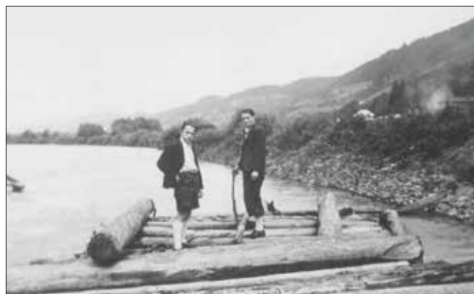
Flößerbrücke für Holztransport an das Heraklithwerk Ferndorf
