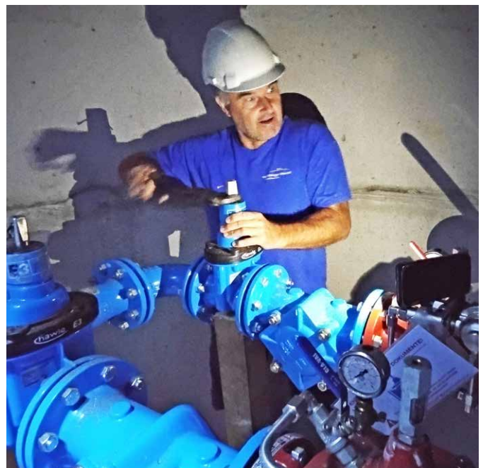
Der aufgrund des Gefälles entstehende hohe Wasserdruck muss mit einer Druckreduzierstation verringert werden. Am Foto Stadtwerke-Mitarbeiter Klaus Berchtold bei der Montage.
