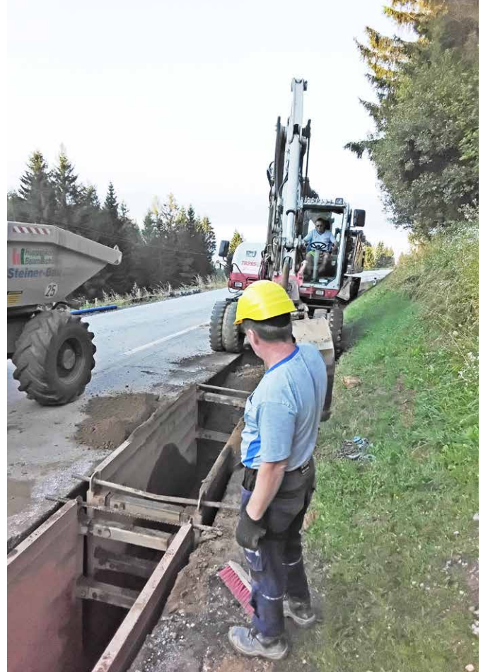
Grabungsarbeiten entlang der Koralmstraße.
