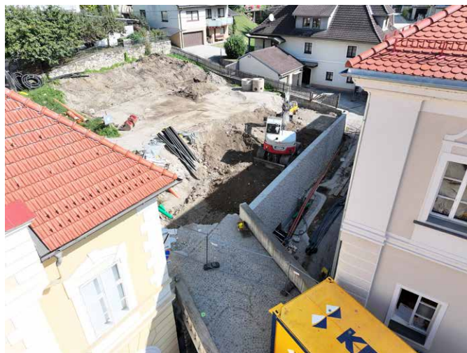
Die neu errichtete Stützmauer am Beginn der Schoßbachstraße.
