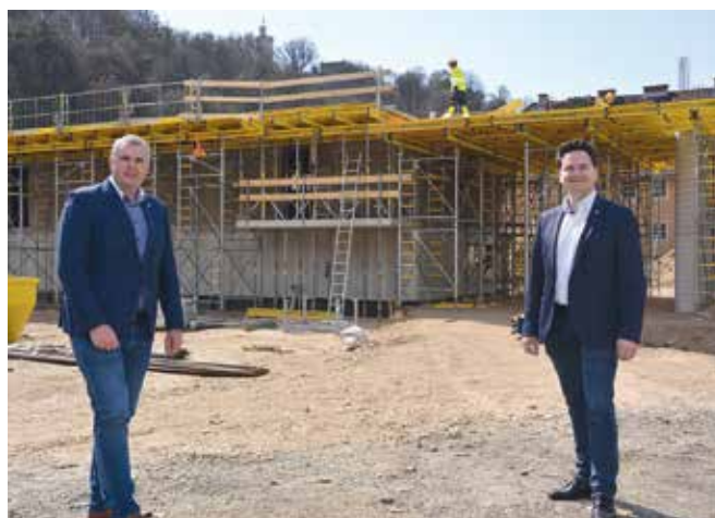
Baustellenbesichtigung durch Bürgermeister Hannes Primus und Wohnbau-Stadtrat Jürgen Jöbstl.
