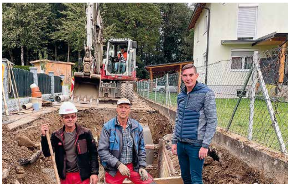
Baustelle am Rikliweg, von rechts: Markus Godez (Stadtwerke), mit Walter Redolfi und Richard Stranig (beide Firma Kostmann).
