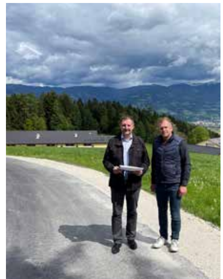
Die Forster Straße mit herrlichem Ausblick auf das Tal wurde saniert. Am Foto Stadtrat Josef Steinkellner mit Straßenmeister Gerald Malz.
