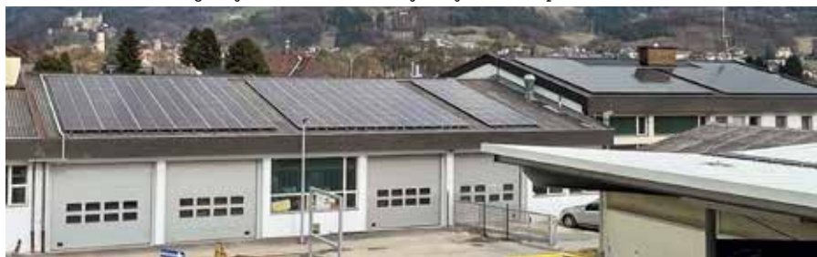
Bild Unten: Die PV-Anlage auf dem Dach des Bauhofes liefert 160 kWp.
