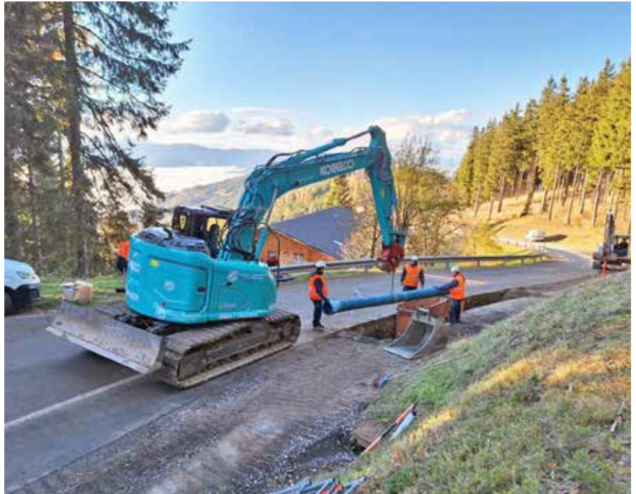
Heuer startet die Baustufe 2 in der Errichtung der neuen Koralpe-Trinkwasserleitung.
