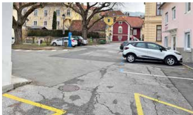
Am Kanalplatz beginnt die 380 Meter lange Kanalsanierung.
