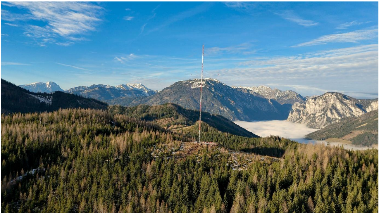
Windmessmast Projekt Windpark Thörl West - Oisching
