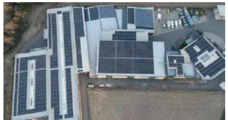
Mit der 700kWp PV-Anlage wurde das grüne Zeitalter eingeläutet. So ist das Unternehmen mittlerweile nahezu energieautark.
