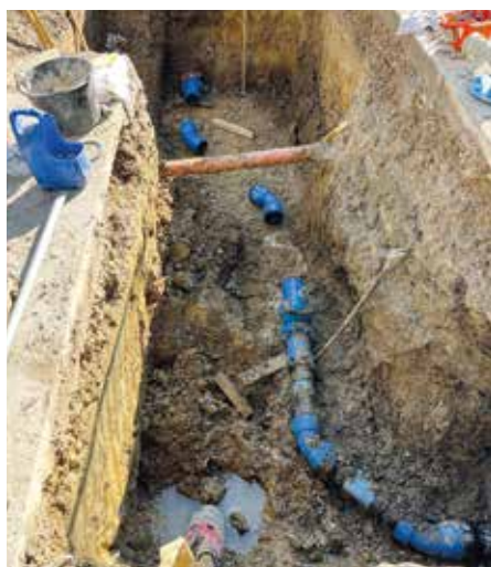
Reparatur eines Wasserrohrbruchs
