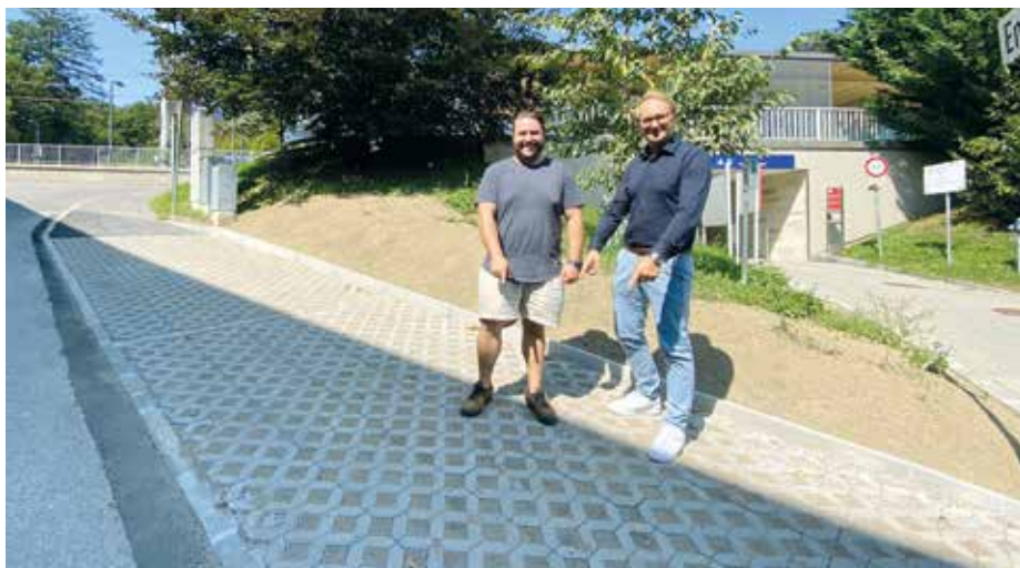
Zwischen den Steinen wurde ein natürliches Granulat zur besseren Versickerung eingesetzt.
