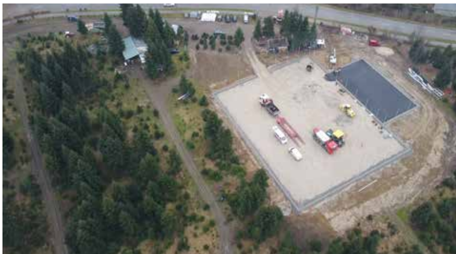
Der Bereich des Kunstrasenplatzes ist bereits für die Aufbringung der Beläge vorbereitet.
