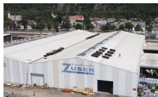
Im Sommer wurden die Solarpaneele mit insgesamt 4.764 PV-Modulen auf den Dächern der Zuser-Werkshallen montiert.
