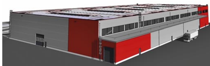
Auf einer Grundstücksfläche von ca. 20.000 Quadratmetern entsteht die neue Logistikhalle mit 10.000 Quadratmetern und eigenem Gleisanschluss.
