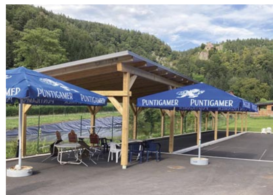
Im heurigen Sommer konnte die Überdachung einer Bahn der neuen Stocksportanlage in Hinterberg fertiggestellt werden.
