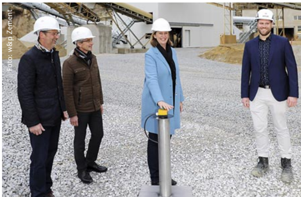
w&p-Standortleiter Robert Schmied, GF Lutz Weber, Landesrätin Barbara Eibinger-Miedl und Bergbauleiter Jürgen Kolp (v. l.) bei der erstmaligen Inbetriebnahme der neuen Rohsteinaufbereitungsanlage.
