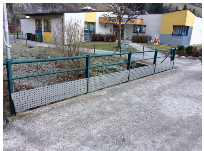
Neue Absturzsicherung bei der Brücke zur Schule und zum Kindergarten
