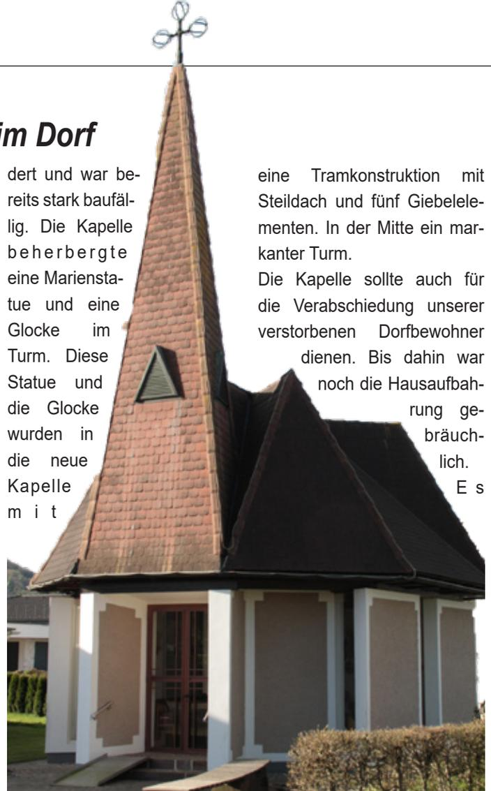
eine Tramkonstruktion mit Steildach und fünf Giebelelementen. In der Mitte ein markanter Turm.
