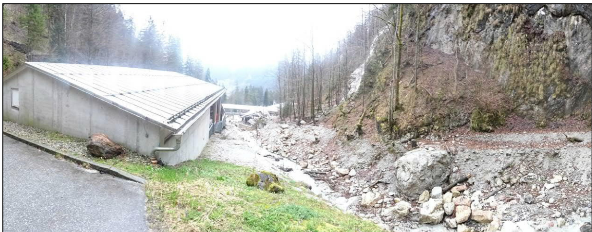
Abbildung 7 Klingerbach mit Anlandungen an der Wendefläche oberhalb des ehem. Rodel-Start (Männer) links im Bild, rechts im Hintergrund Abstürze des Hochmaisfeldgrabens (April 2023, Blick nach Osten)
