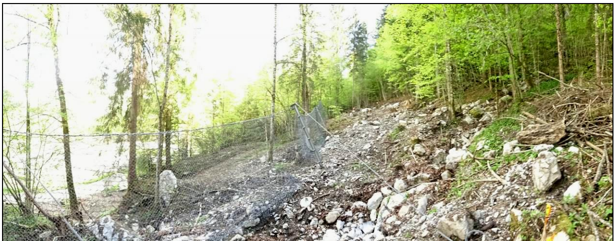
Abbildung 16: Schuttfur / Geländeanriss im Innenbestand (Mai 2023, Blick nach Norden)
