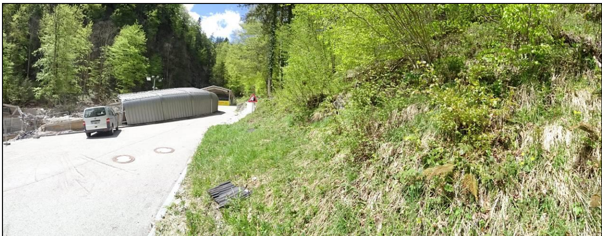
Abbildung 9: nördlicher Unterhang entlang der Fahrstraße mit Altgras- und Staudenfluren im Übergang zum Waldsaum, im Hintergrund ehem. Rodel-Start der Männer (Mai 2023, Blick nach Westen)
