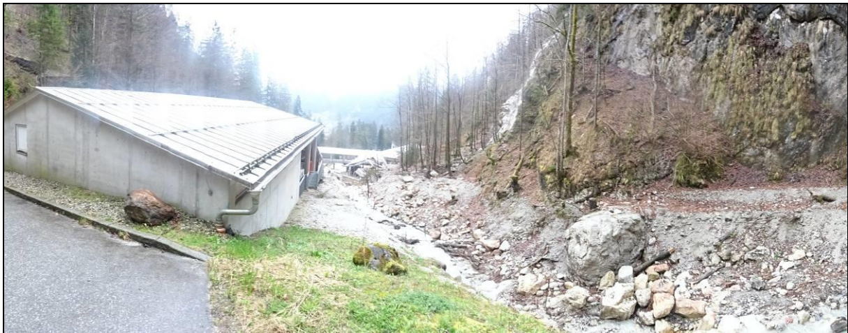
Abbildung 7: Klingerbach mit Anlandungen an der Wendefläche oberhalb des ehem. Rodel-Start (Männer) links im Bild, rechts im Hintergrund Abstürze des Hochmaiefeldgrabens (April 2023, Blick nach Osten)
