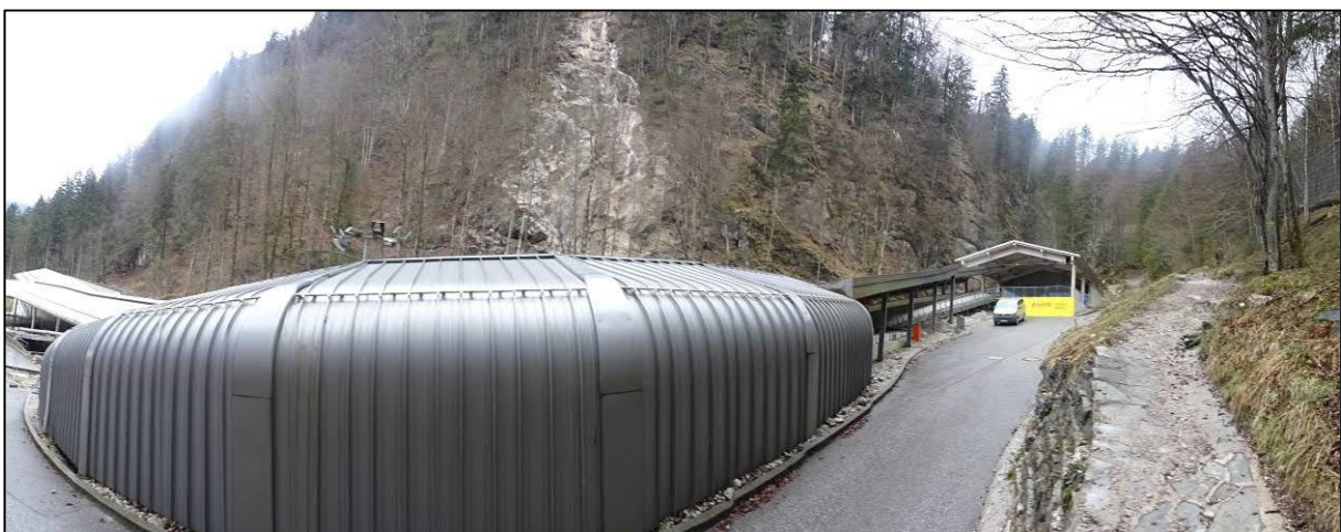
Abbildung 26 rückzubauender Teilabschnitt zw. Rodelstart Herren (rechts im Bild) und Kurve 4 bzw. dem Bobstart, im Hintergrund der Absturz des Hochfeldmaisgrabens (April 2023)
