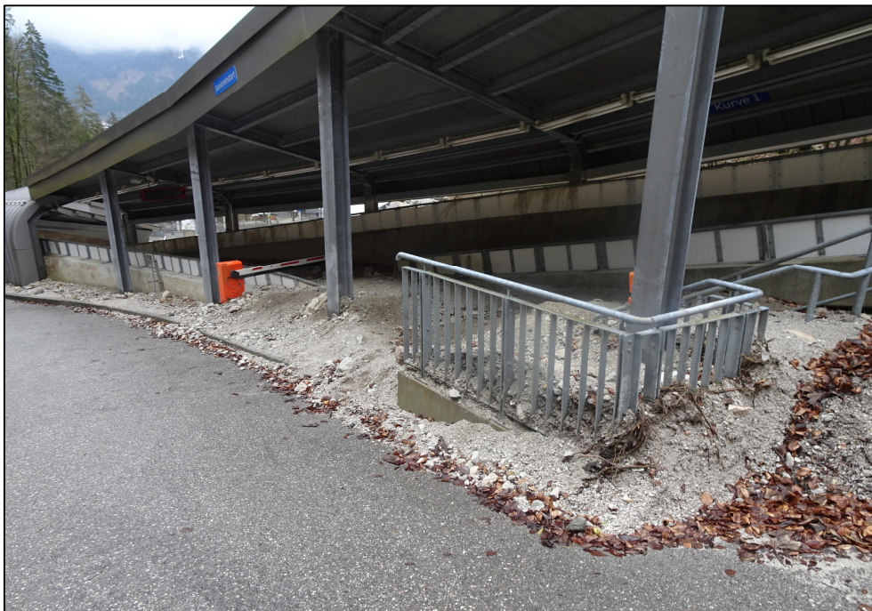
Abbildung 25 Dachkonstruktion am Juniorenstart bzw. an Kurve 1 (April 2023)
