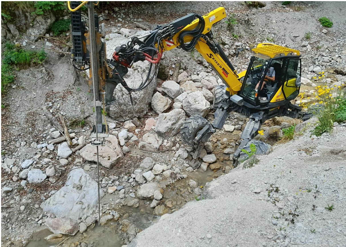
Abb. (5): TB 5 ; Sohle Klingerbach, etwas unterhalb Rodelstart (20.06.2023)
