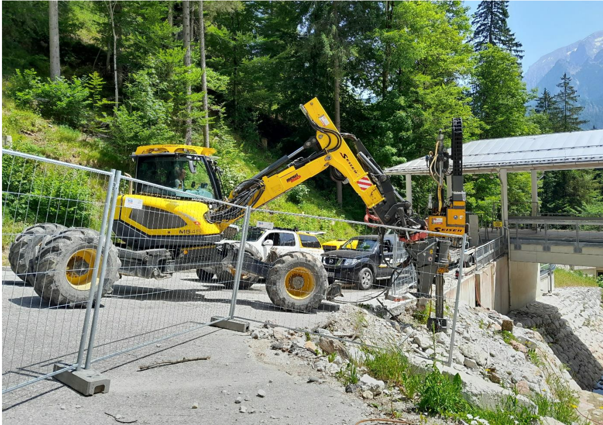
Abb. (19): TB 23 ; nördliche Talseite, oberhalb Verladebrücke (21.06.2023)
