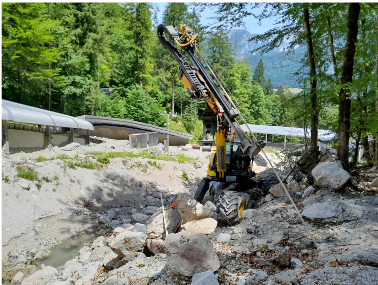
Abb. (9): TB 9 ; Schuttbereich rechts vom Klingerbach (20.06.2023)
