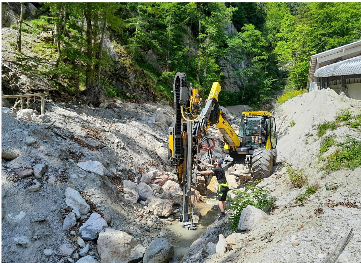
Abb. (2): TB 2 ; Derzeitige Sohle Klingerbach (20.06.2023)
