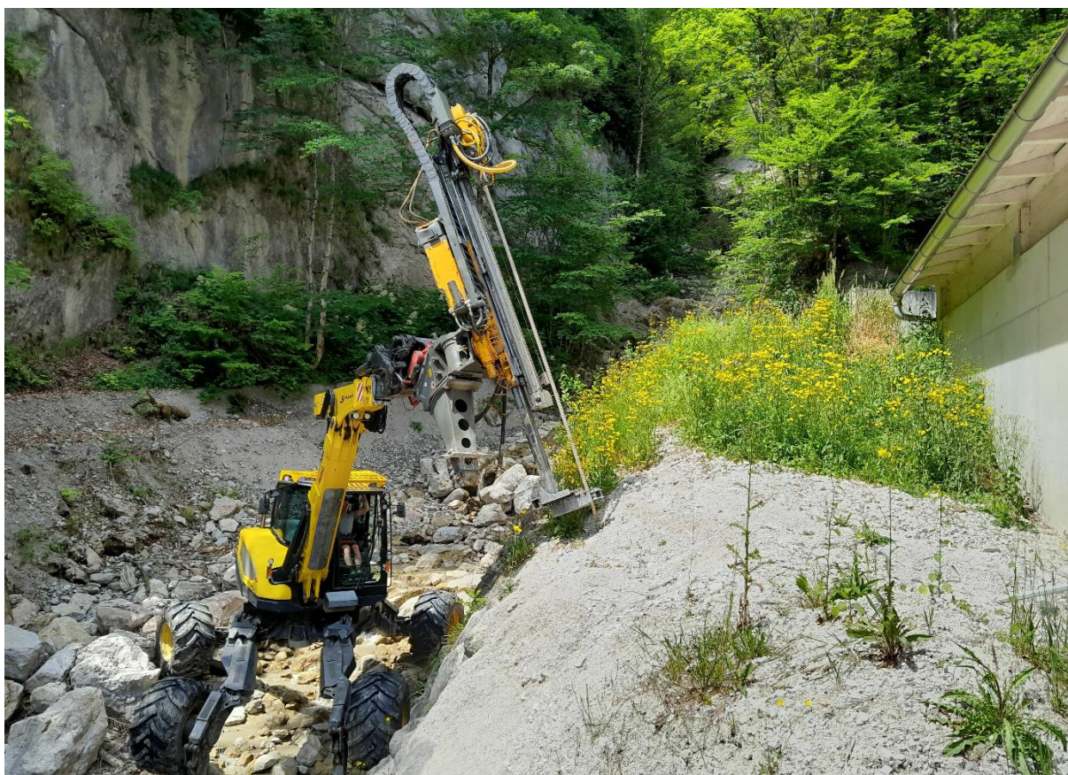
Abb. (4): TB 4; oberhalb linker Böschung beim Rodelstart, schräg (20.06.2023)
