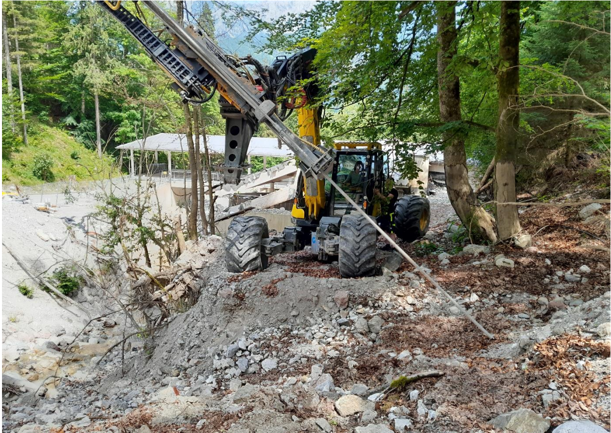
Abb. (13): TB 16 ; südlicher Hangfuß, Bereich Zulauf Seitenbach (20.06.2023)
