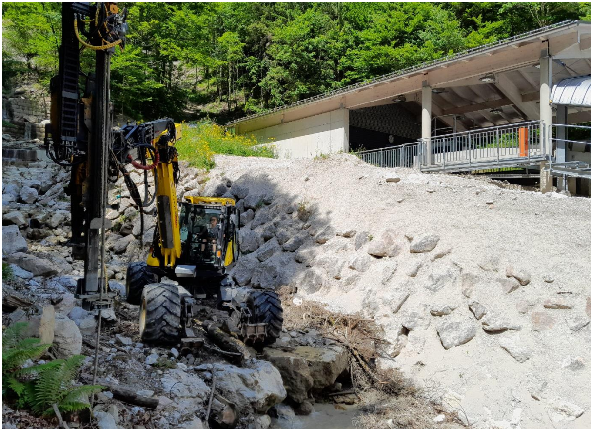
Abb. (6): TB 6 ; Hangfuß rechte (südliche) Talflanke (20.06.2023)
