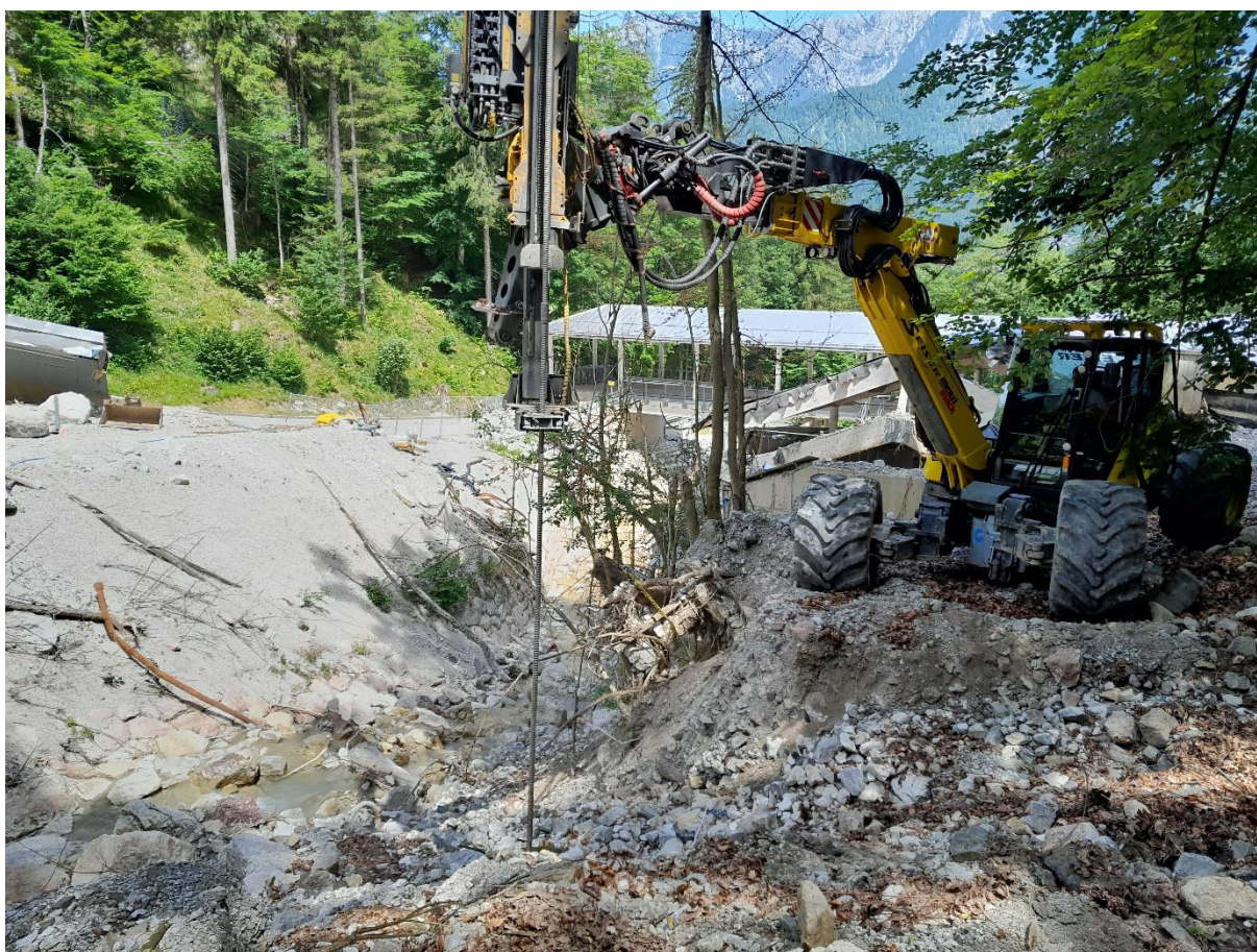
Abb. (12): TB 14 ; Einmündung Seitenbach in Klingerbach (20.06.2023)
