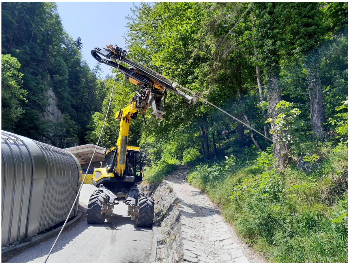
Abb. (23): TB 28 ; linke (nördliche) Talflanke, oberhalb Fußweg, ca. Schnitt 10 (21.06.2023)
