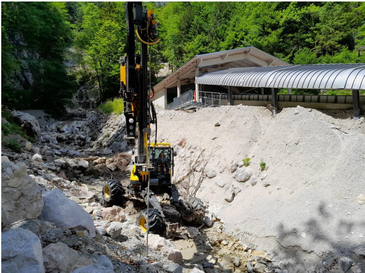
Abb. (8): TB 8 ; rechts des bestehenden Bachbettes (20.06.2023)
