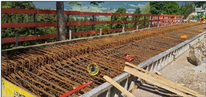
Ein zentraler Bestandteil der Maßnahme war die Sanierung von drei bestehenden Stützbauwerken. Diese wurden durch den Einbau von Stützbalken sowie eine Pfahlgründung mit insgesamt 105 Pfählen stabilisiert, um die Hanglage dauerhaft zu sichern. Für die Ausführung der Betonarbeiten wurden rund 390 Kubikmeter Beton sowie etwa 70 Tonnen Baustahl verbaut. Zusätzlich wurde die
