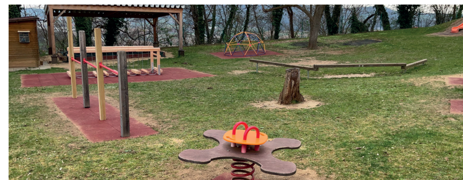
▲ Erneuerung der Fallschuttmatten beim Spielplatz des Kindergartens Straden
