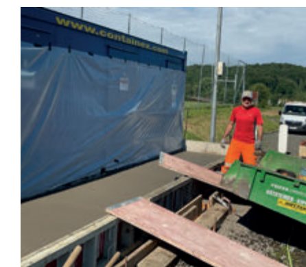
▲ Barrierefreier Zugang zum WC-Container
