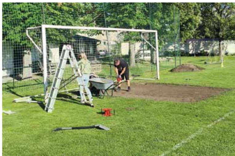
Der Fußballplatz wurde auf Vordermann gebracht
