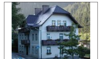
„Ehem. Amtshaus“, Kirchenviertel 85
