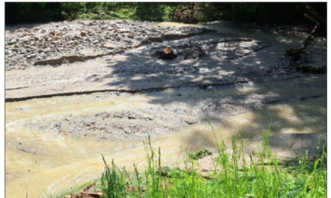
Nießnitzbach hm 20,98; Geschiebeablagerung hinter verfülltem Wildholzrechen, Räumung
