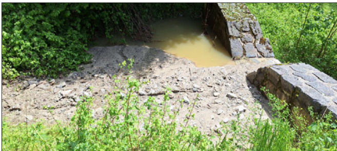
Luegerbach, hm 0,33; verlandete Betonsperre, Teilräumung
