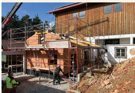
Abriss des alten Hofgebäudes aufgrund von Brandschutzvorschriften und Errichtung des neuen Hofladens.
