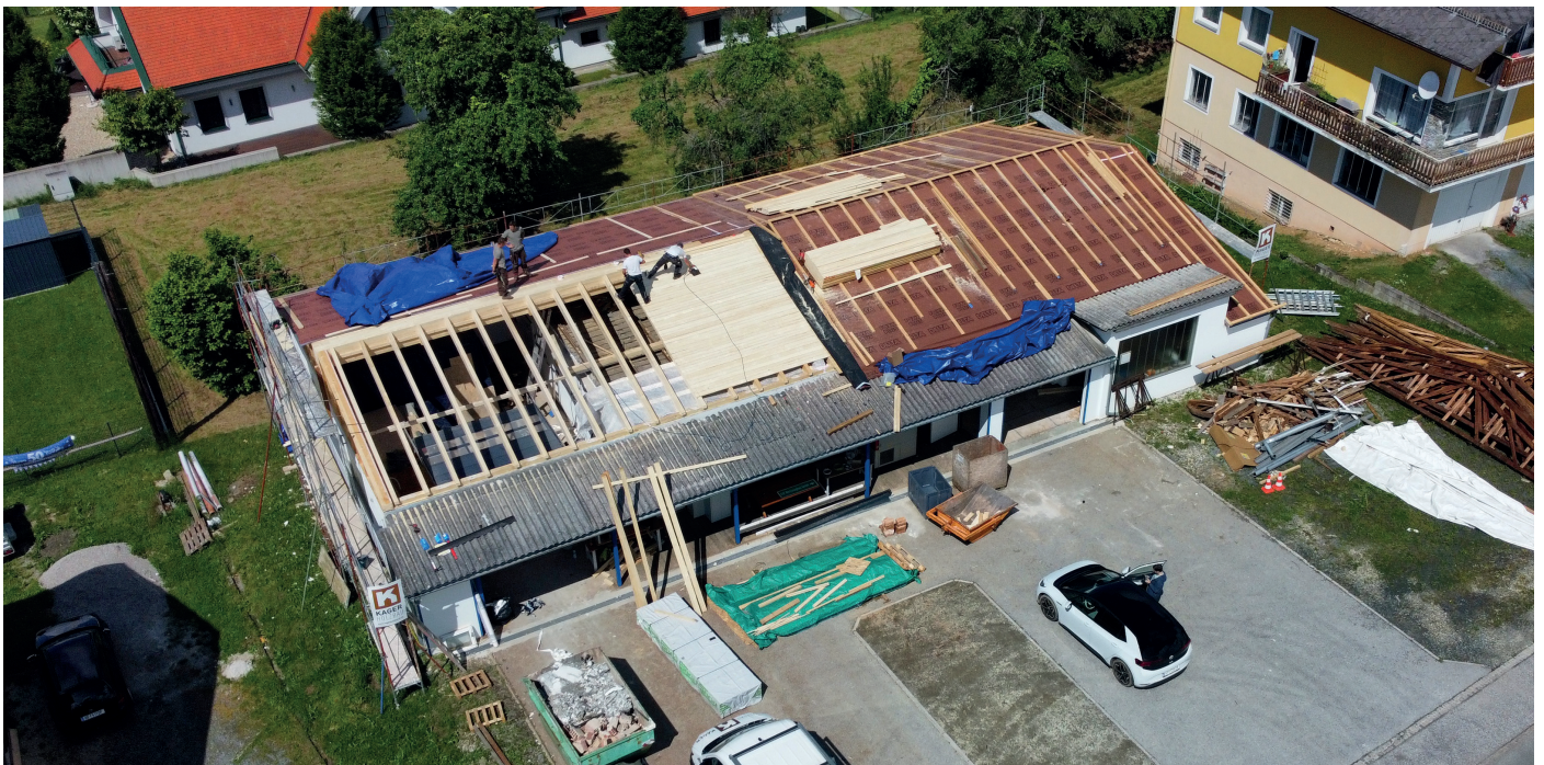
Modernisierungsarbeiten bei E.L.T.: Arbeiten am Hallendach während der intensiven Umbauphase.
