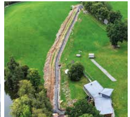
Im Herbst wurden neue Wasserleitungen zu den Schneeeerzeugern verlegt.
