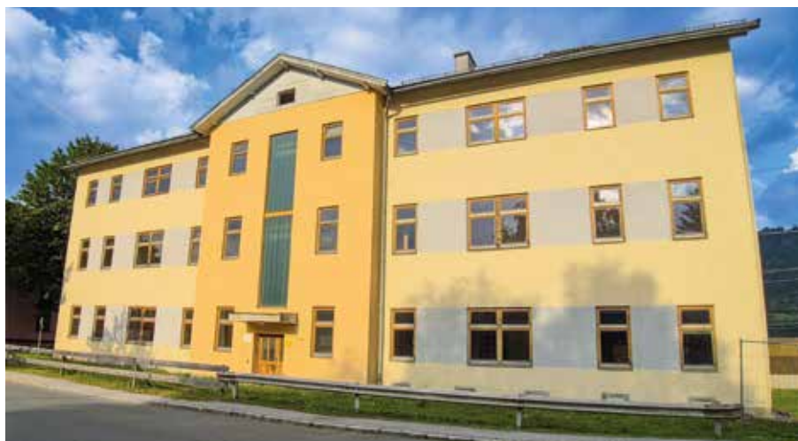
Im September startet der Abbruch des ehemaligen Wohngebäudes „Dorfheimerstraße 3“
