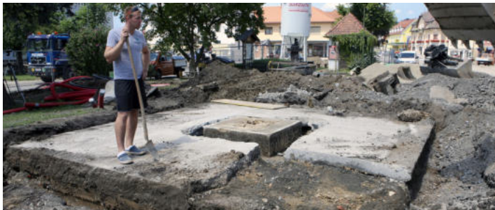
16. Juli 2014. Unter den Stainzerplatten ist ein 30 cm dicker Betonmantel. Die Außenmaße sind 5,2x5,2 Meter).
