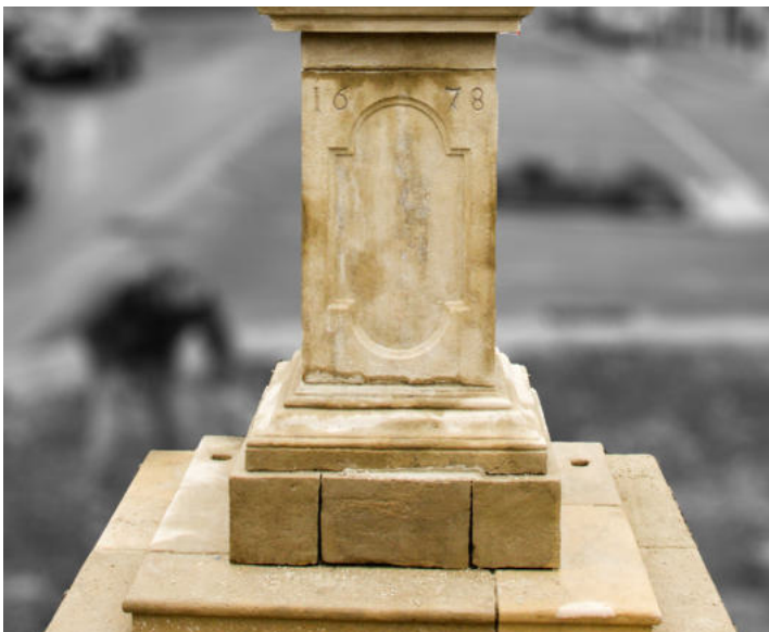
Die restaurierten Stufen, darüber das Podest, das Fußgesimse, der Postamentschaft und das Kranzgesimse.
