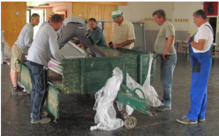
Austausch der Fenster bei der Festhalle Kohlberg
