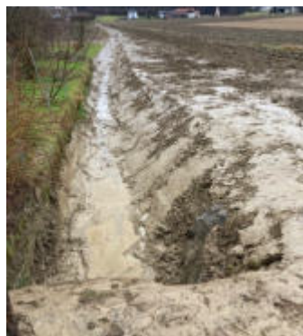
Graben von der Landesstraße in Richtung Mühlackerweg
