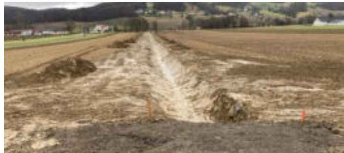
Graben von der Landesstraße in Richtung Mitterweg
