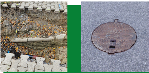
Reparatur defekter Kanaldeckel
