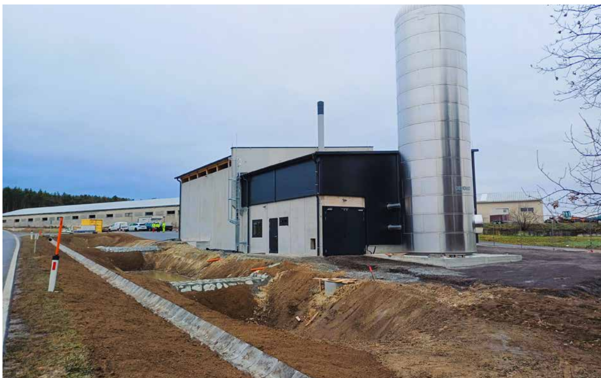
Foto: Außenansicht des Heizwerks
