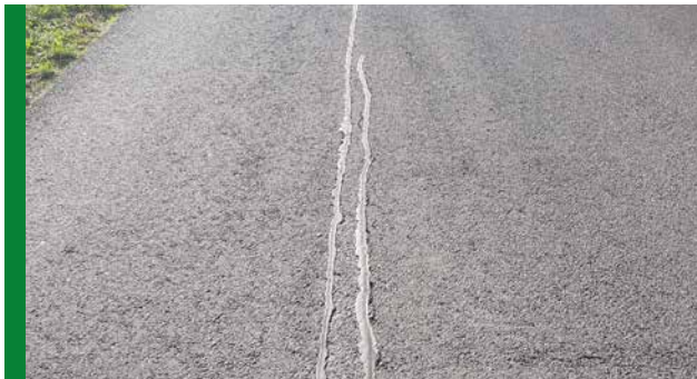
Ausbesserungsarbeiten auf Gemeindestraßen und Güterwegen (Versiegelung von Rissen)
