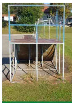
Wiederanbringung Absturzsicherung beim Skaterplatz
