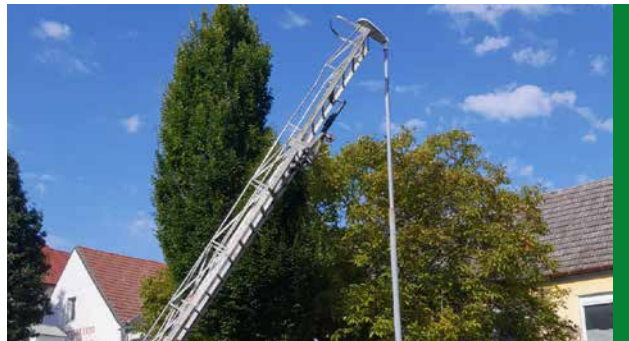
Reparatur Straßenbeleuchtung nach Blitzschlag
