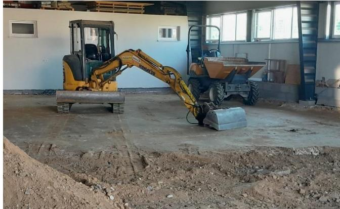
Im Innenbereich wurde die Fassade saniert, der Asphaltboden herausgenommen und die Bodenplatte neu betoniert. Die Arbeiten wurden auch unter Mitarbeit unserer Gemeindebediensteten durchgeführt.
