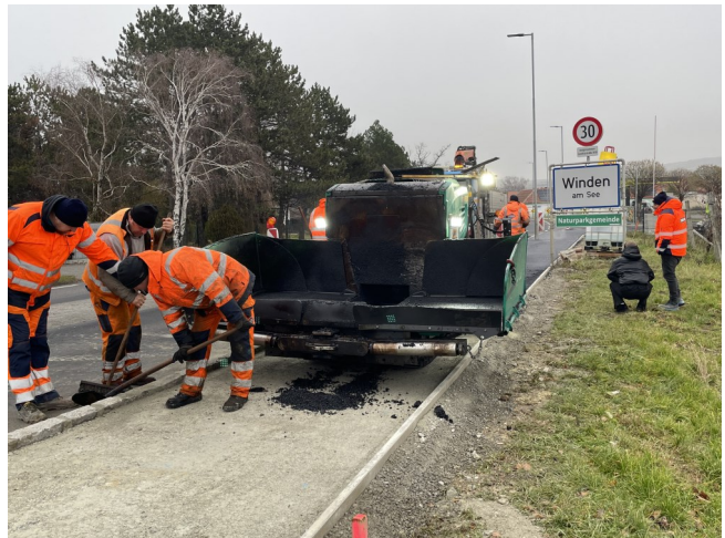
Radbegleitweg-Errichtung durch Firma Swietelsky
