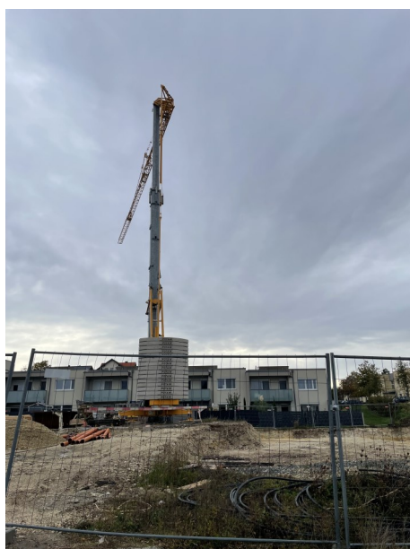
Baustelle in der Rudolf Heinz Straße
