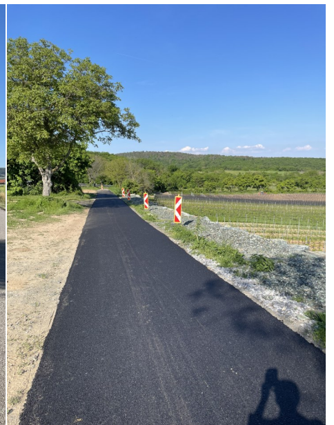
Oberer Spiegelweg: Sanierung
