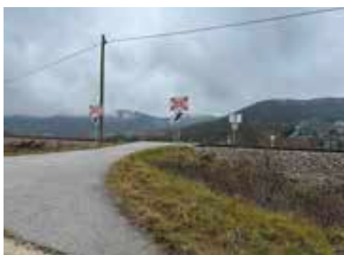
Der Bahnübergang am Feldweg Richtung Weikersdorf soll geschlossen werden.
