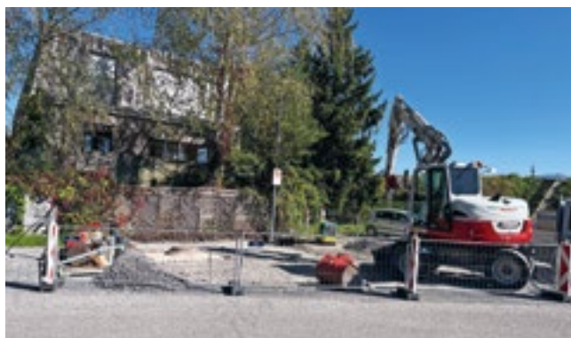
Aktuell finden die Fundamentarbeiten statt.
