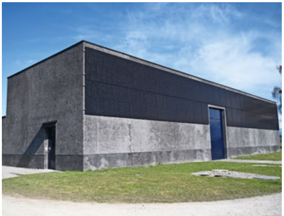
Die neue Photovoltaikanlage speist die Haustechnik des Wasserwerks und ermöglicht stabile Stromerträge.
