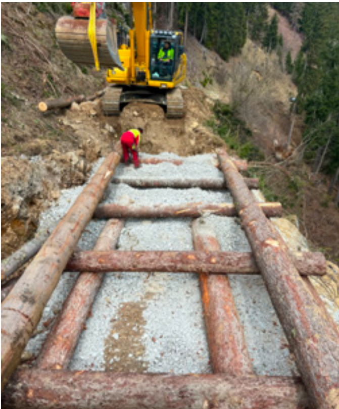
Errichtung einer Kraierwand
