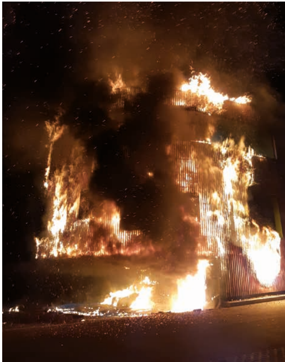
Die brennende Fassade der VS Kappl in der Nacht auf den 07. August 20
