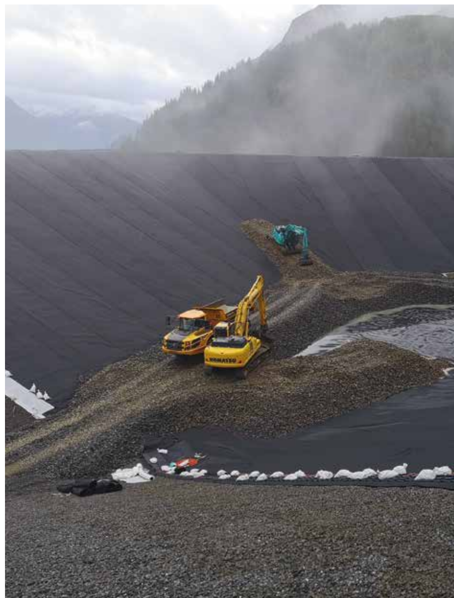
Baustelle Speicherteich Dias II
