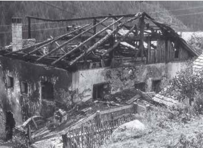
Das Haus Zangerle in Wiese nach dem Brand
