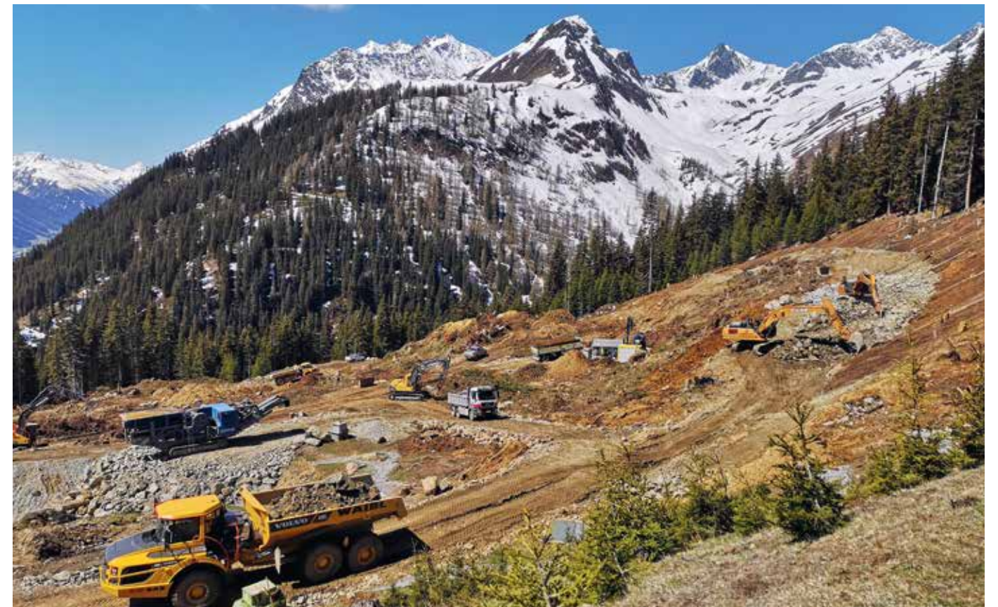
Baustelle Speicherteich Dias II
