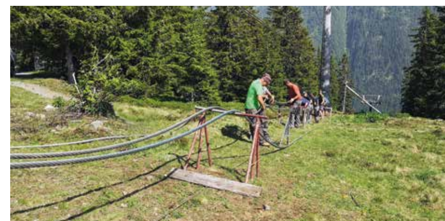
Spleißarbeiten an der Alblittbahn
