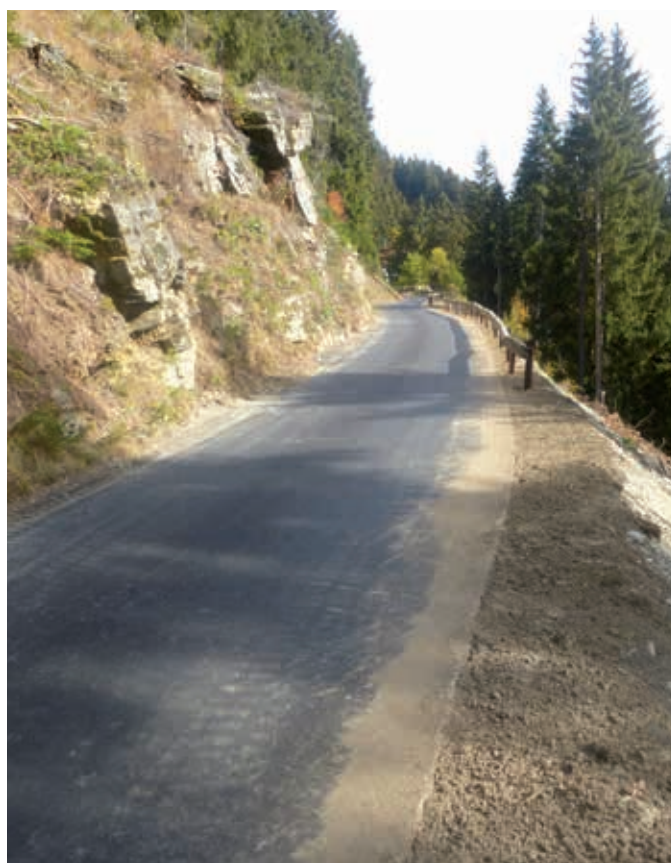
Sanierung der Straße nach Ahornach
