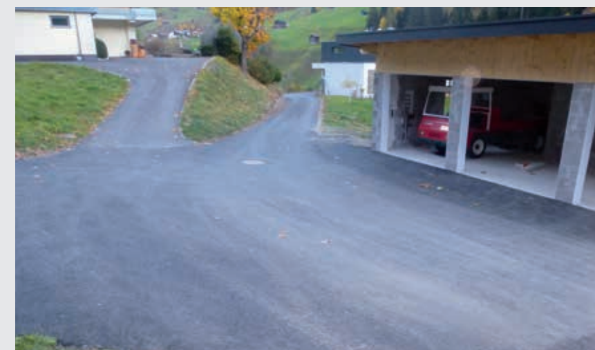
Sanierung im Weiler Moos
