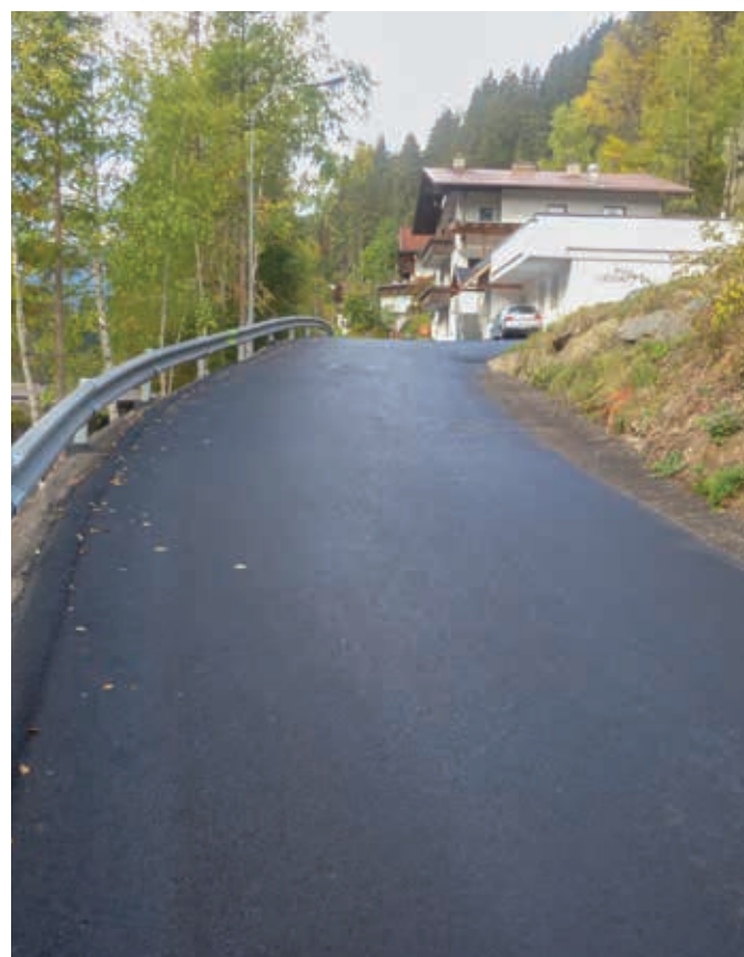
Sanierung der Straße in der Siedlung Holdernach
