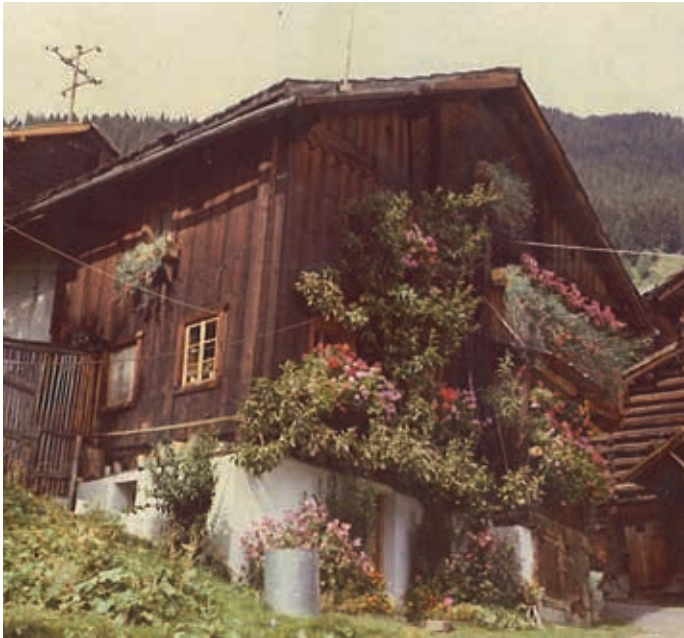
Haus Nr. 147 Obermühl im Jahr 1976, nunmehr vor 3 Jahren abgetragen
