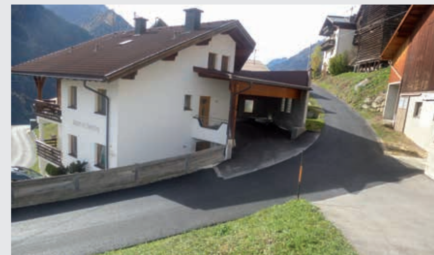
Sanierung in Plattwies
