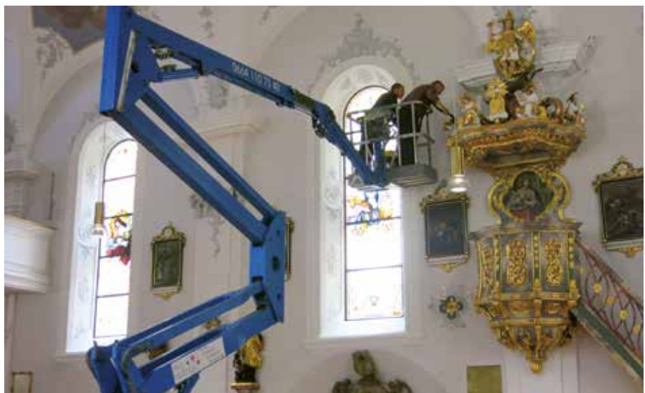
Kirchenreinigung mit Fassadensteiger
