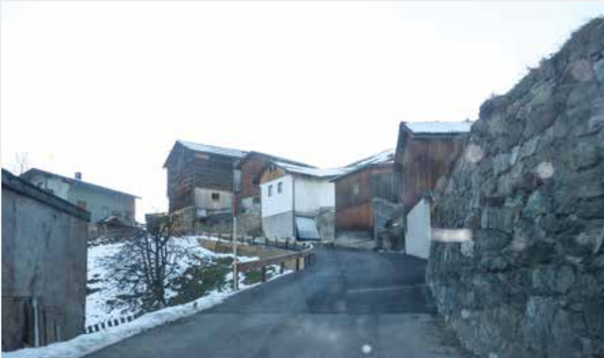
Straßensanierung in Oberbichl
