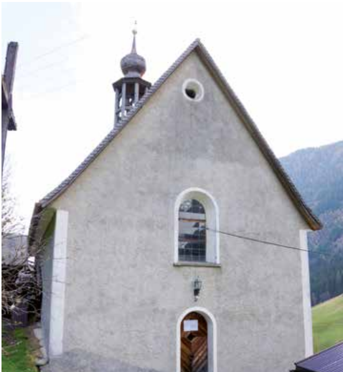
Die Kapelle St. Martin vor der Renovierung
