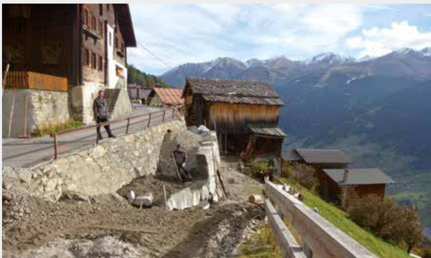
Ausbau der Kehre vor Pirchegg
