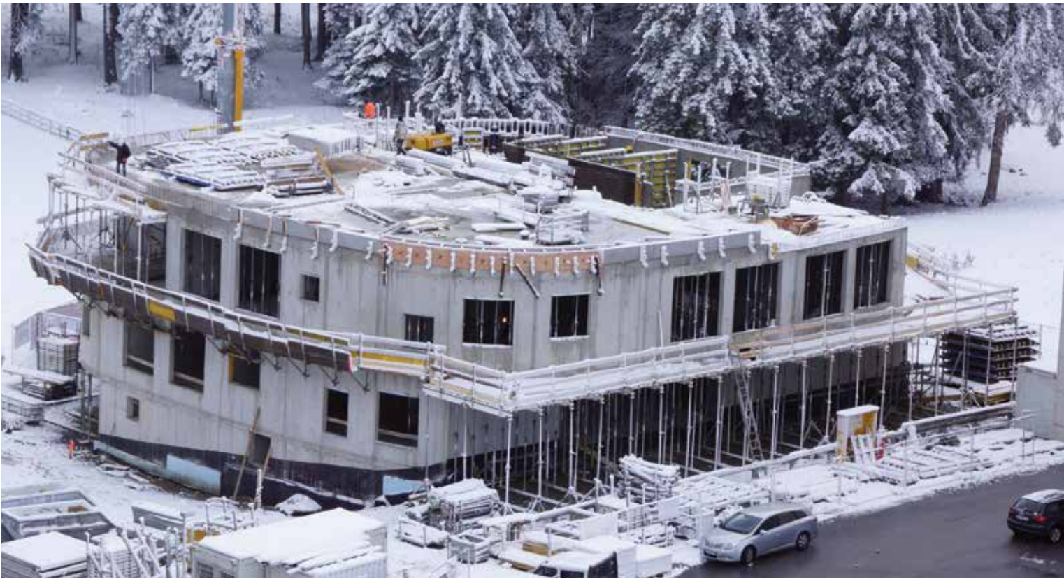
Rohbau der neuen Volksschule Kappl
