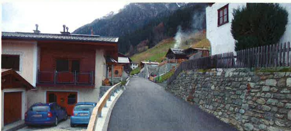
Verbesserungen, Sanierungen und Ausbauten der Gemeindestraßen
