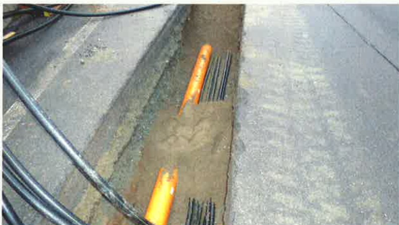
Weiterführung der Erdgasleitung
