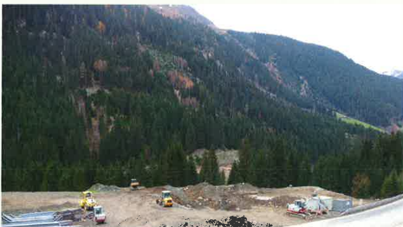
Erschließung des Gewerbegebietes im Ulmicherwald
