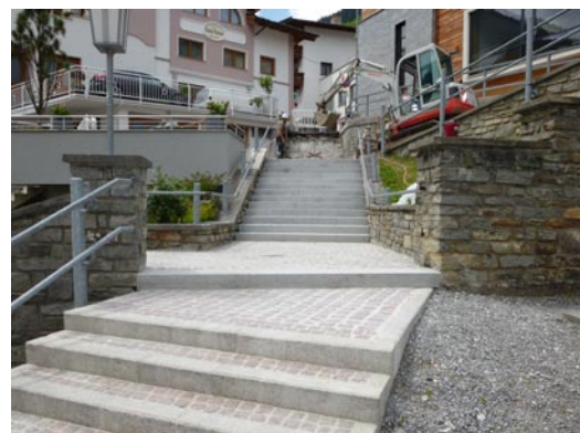
Erneuerung des Zuganges beim Friedhof.
