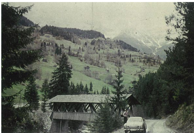
Die „Maientalbrücke“ im Frühjahr 1965. Foto: Kurt Dörner, Frankfurt a. M.
