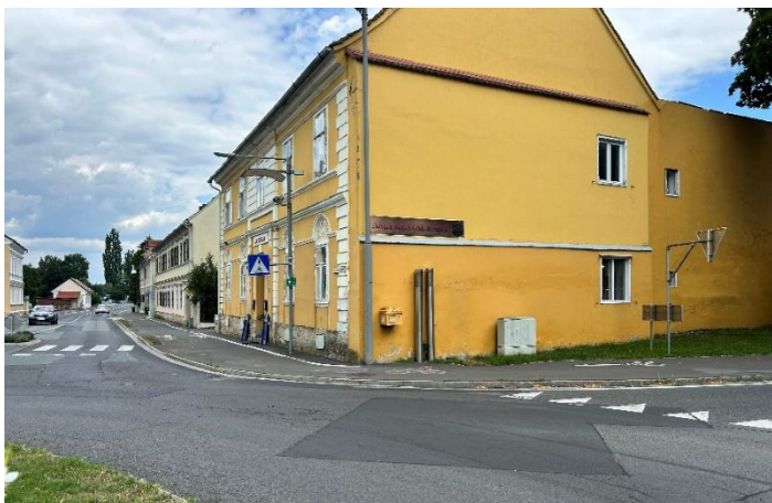
Sicht auf den Geh- und Radweg vom Kreisverkehr
